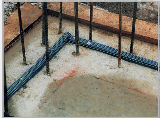
Montering med festegitter og spiker
