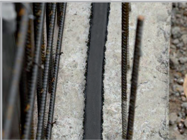
Montering med svellebåndslim
